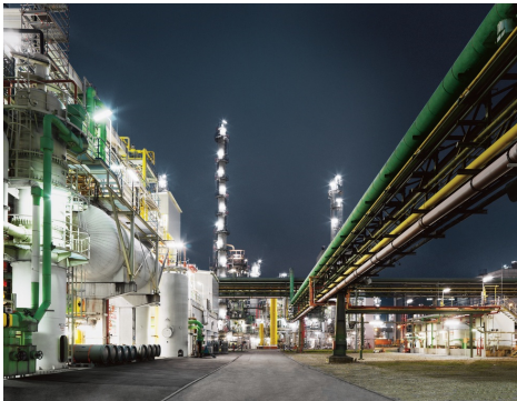
Werk Burghausen bei Nacht. Kurze Wege verbinden in Burghausen ideal unterschiedliche Produktionen und Prozesse.
