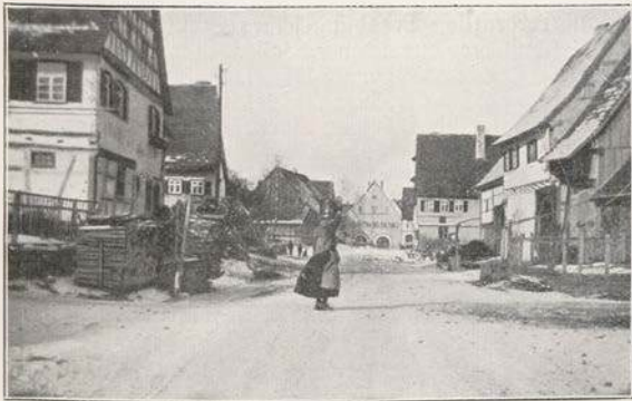
Die „Gasse“ in Ostdorf, von Süden gesehen.
