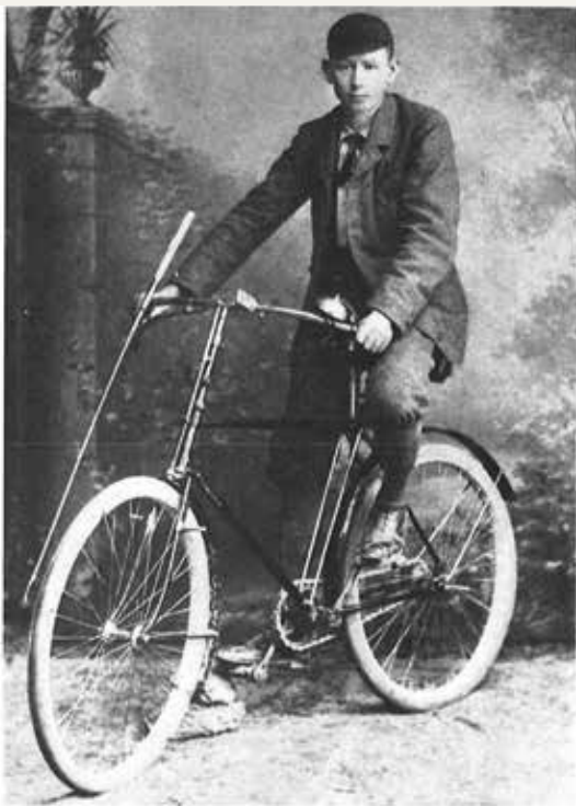
Leonhard Moll im Jahre 1894 auf seiner täglichen Baustellenrundfahrt
